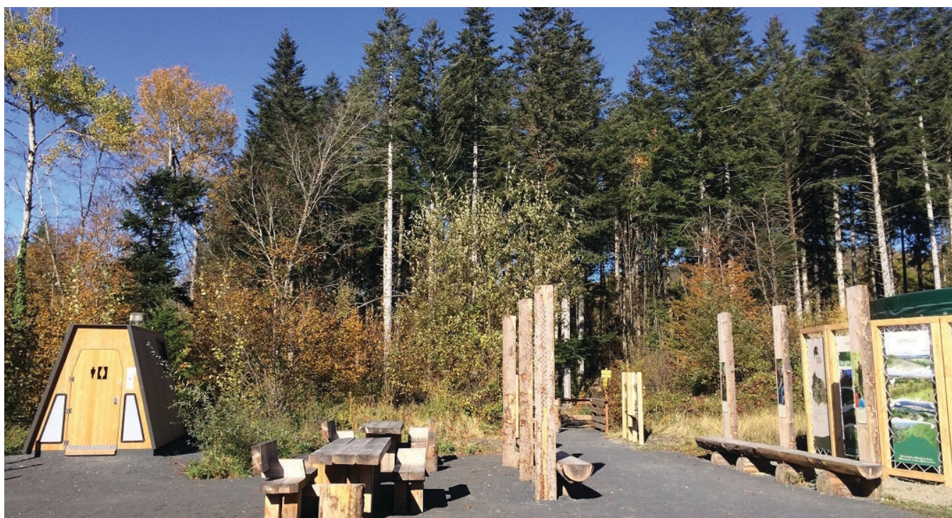
Les installations de confort et les toilettes sèches dans le bois de la Comté réalisées in situ avec les épicéas de la forêt.
