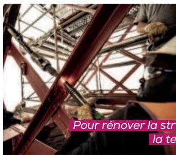
Pour rénover la structure métallique, les ouvriers ont employé la technique traditionnelle du rivetage à chaud.
