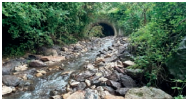
Les travaux sur le pont traversant le ruisseau de Pignols (Vic-le-Comte) ont permis au cours d'eau de retrouver un aspect plus naturel.
