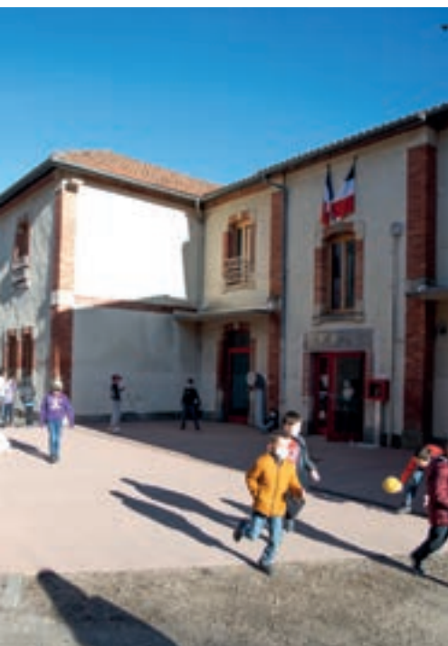
L'école de Saint-Rémy-sur-Durolle a fait l'objet d'une rénovation thermique exemplaire.
